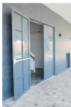
PORTAS DE EMERGÊNCIA (CORTA-FOGO)
