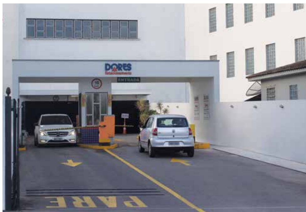
Estacionamento para 400 veículos.
