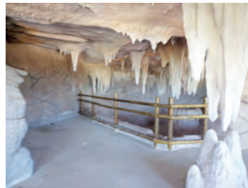
Tematização da Gruta da Torre: concluída .
