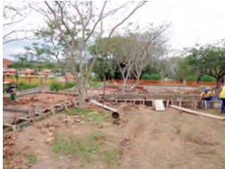
Início do acesso principal.
