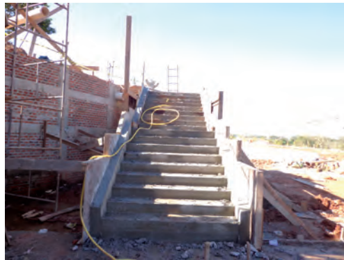
Escada de acesso principal.
