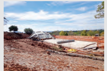
Sanitários e lancheria da praia no início e no final de abril: concluída .
