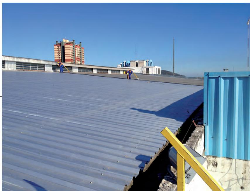
O Ginásio Poliesportivo está em nova fase de suas obras. Com a conclusão das adaptações exigidas pelo Corpo de Bombeiros, e consequente aumento de população, o Ginásio receberá, assim como o La Sagra, um novo telhado de aluzinc, em substituição ao de alumínio. A área total de cobertura substituída é de mais de 3 mil metros quadrados.
