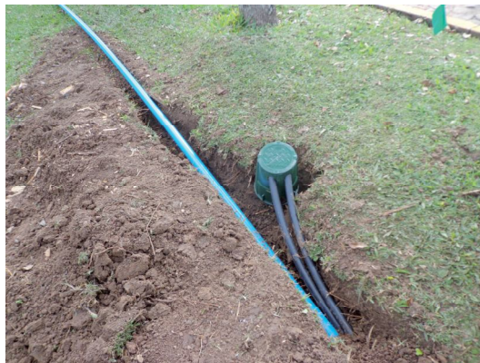
Iniciaram-se as obras da irrigação do Dorens Praia Park, e estão sendo colocadas as canalizações e as caixas de inspeção.
