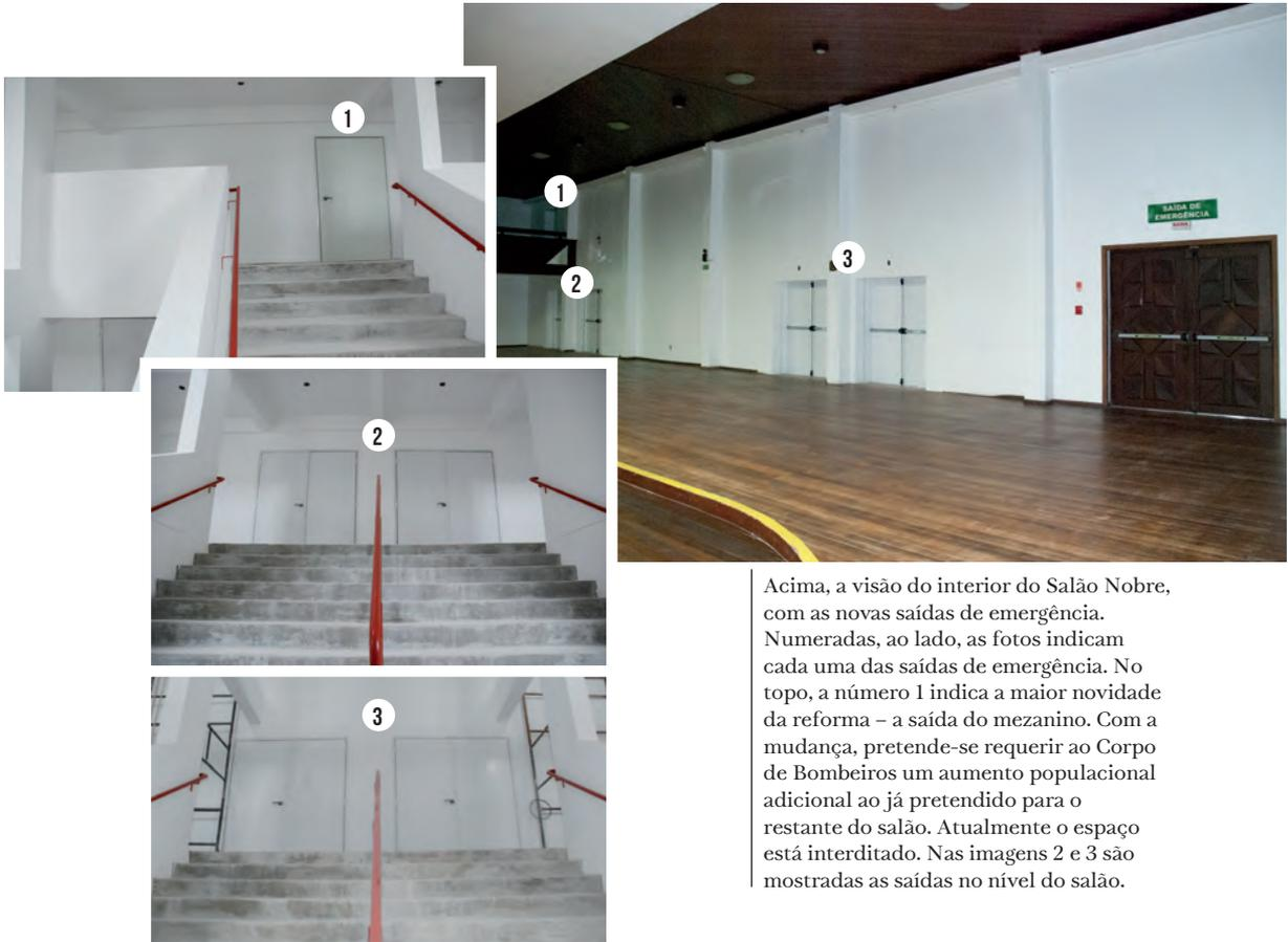
Acima, a visão do interior do Salão Nobre, com as novas saídas de emergência. Numeradas, ao lado, as fotos indicam cada uma das saídas de emergência. No topo, a número 1 indica a maior novidade da reforma – a saída do mezanino. Com a mudança, pretende-se requerir ao Corpo de Bombeiros um aumento populacional adicional ao já pretendido para o restante do salão. Atualmente o espaço está interditado. Nas imagens 2 e 3 são mostradas as saídas no nível do salão.
