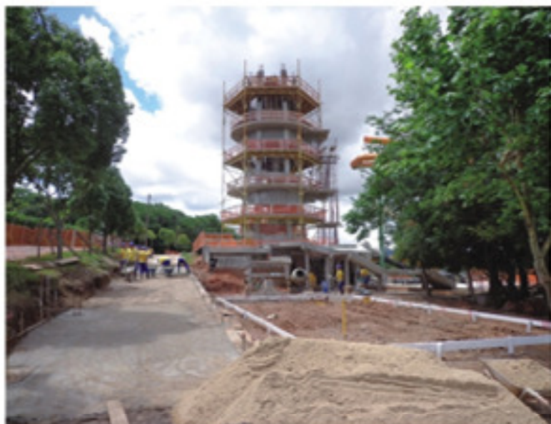
Estão sendo construídas as formas da 3ª plataforma da torre e demarcados os sanitários que servirão esse setor
