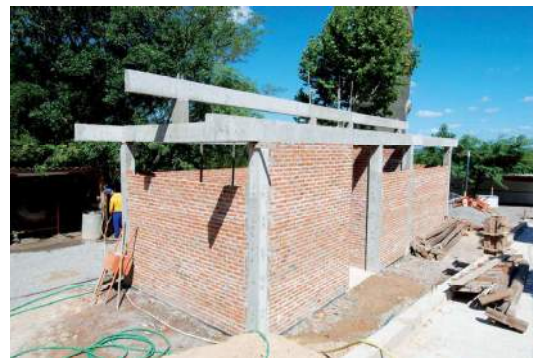
SANITÁRIOS A - 30% concluído
